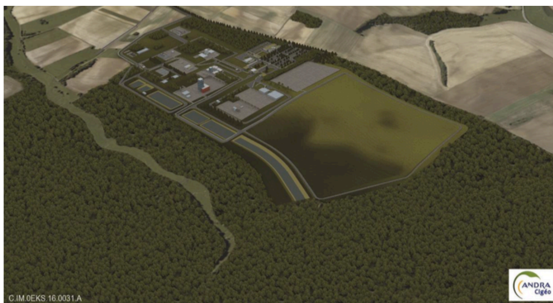
Figure 6 Vue illustrative de la zone puits (2)
