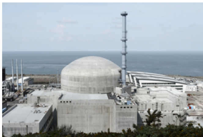
Vue sur le chantier EPR Flamanville 3 depuis la falaise © EDF Médiathèque - Alexis Morin - Antoine Soubigou / tous droits réservés
