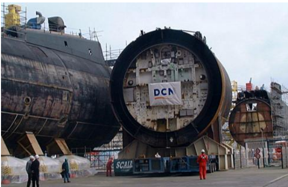
Extraction de la tranche de réacteur d'un SNLE, avant ressoudage de la coque posée sur les marcheurs.
