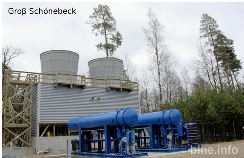
Les tubages sont en acier ordinaire couvert de résine époxy. La pression est gardée entre 1 et 2,2 MPa pour éviter le dégazage. Il y a les habituels (au Danemark et en Allemagne) filtres grossiers ( $> 10\text{-}20\ \mu\text{m}$ ) à la sortie du puits de production et les fins ( $> 1\text{-}2\ \mu\text{m}$ ) avant le puits de réinjection (changeables sans arrêter la boucle).
